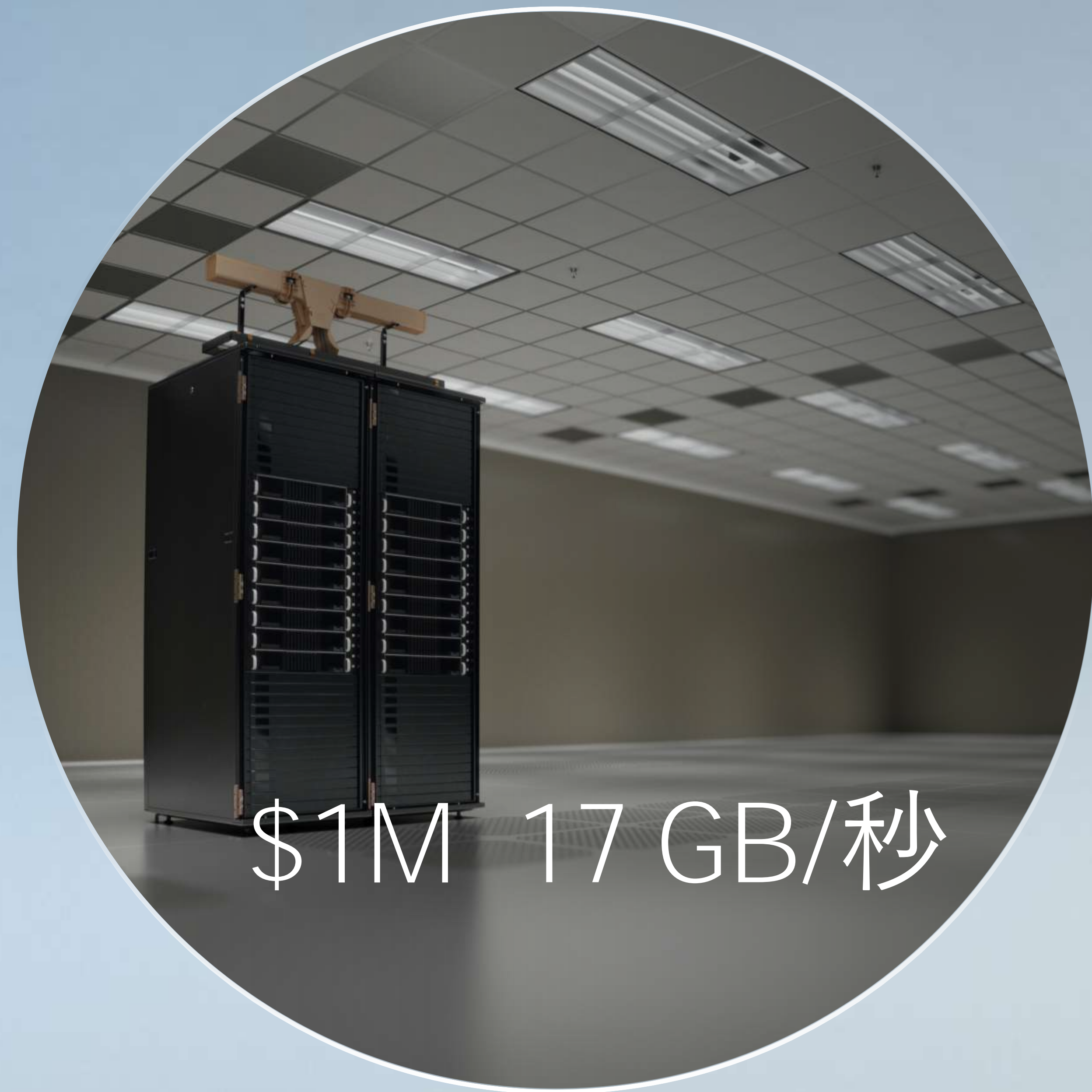
TPCx-BB @ SF 10K で 17 GB/秒のスループット $1M | 18.2U CPU システム | 2 ラック | 16 kW
